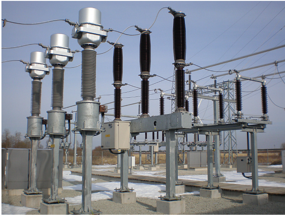
Joonis Elegaasüliti (esiplaanil voolutrafo)
