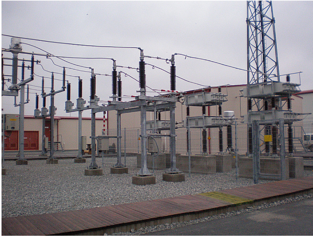
Joonis 4.ccc Horisontaalpinnas pöörduvate nugaodega kahesambaline lahküliti Nimipinge 110 kV, nimivool 1200 A
